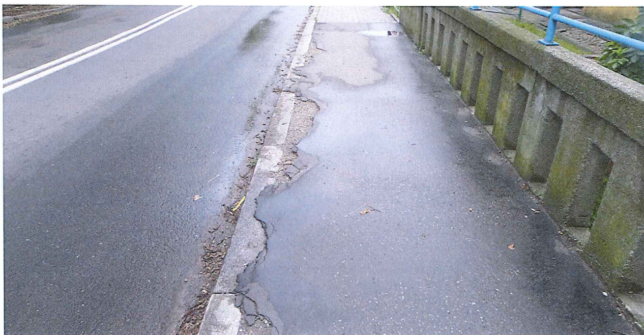
Fot. 10 Nawierzchnia chodnika
