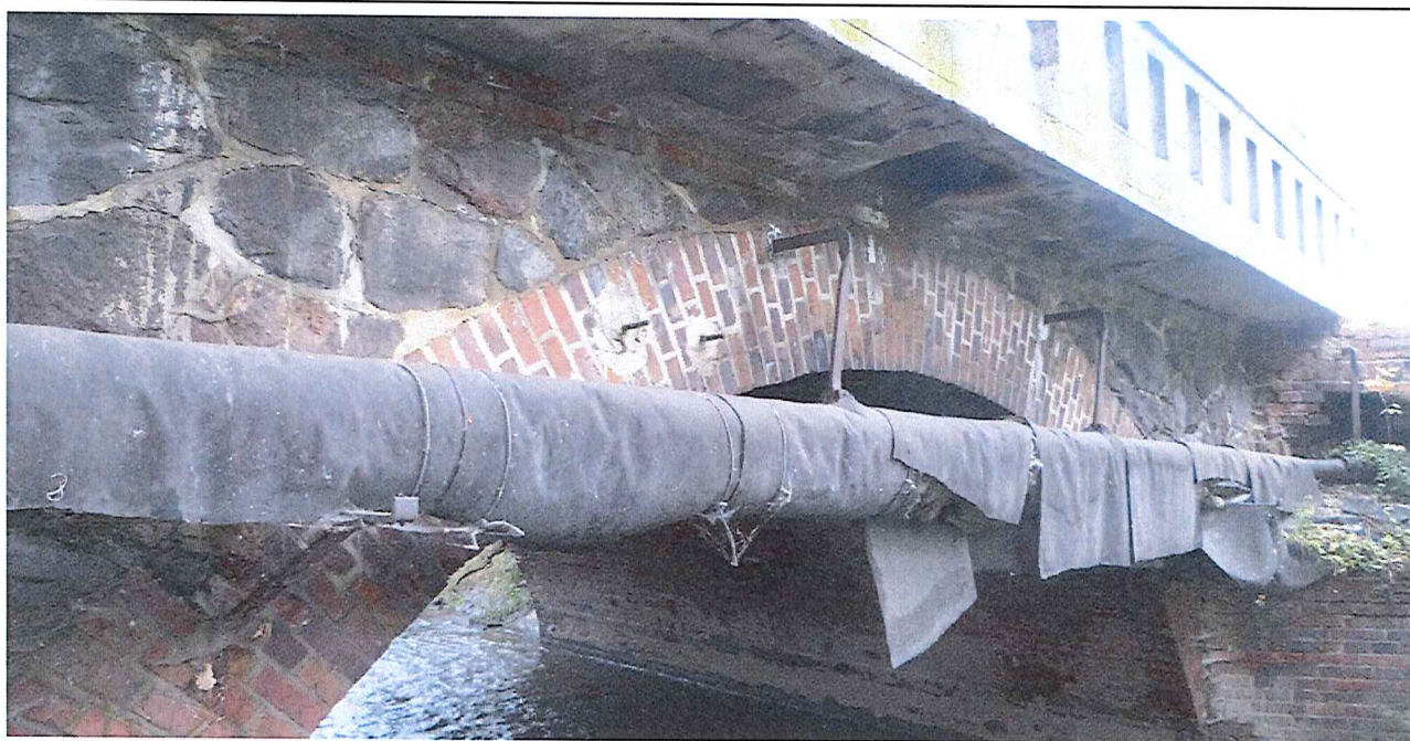
Fot. 12 Widok urządzeń obcych
