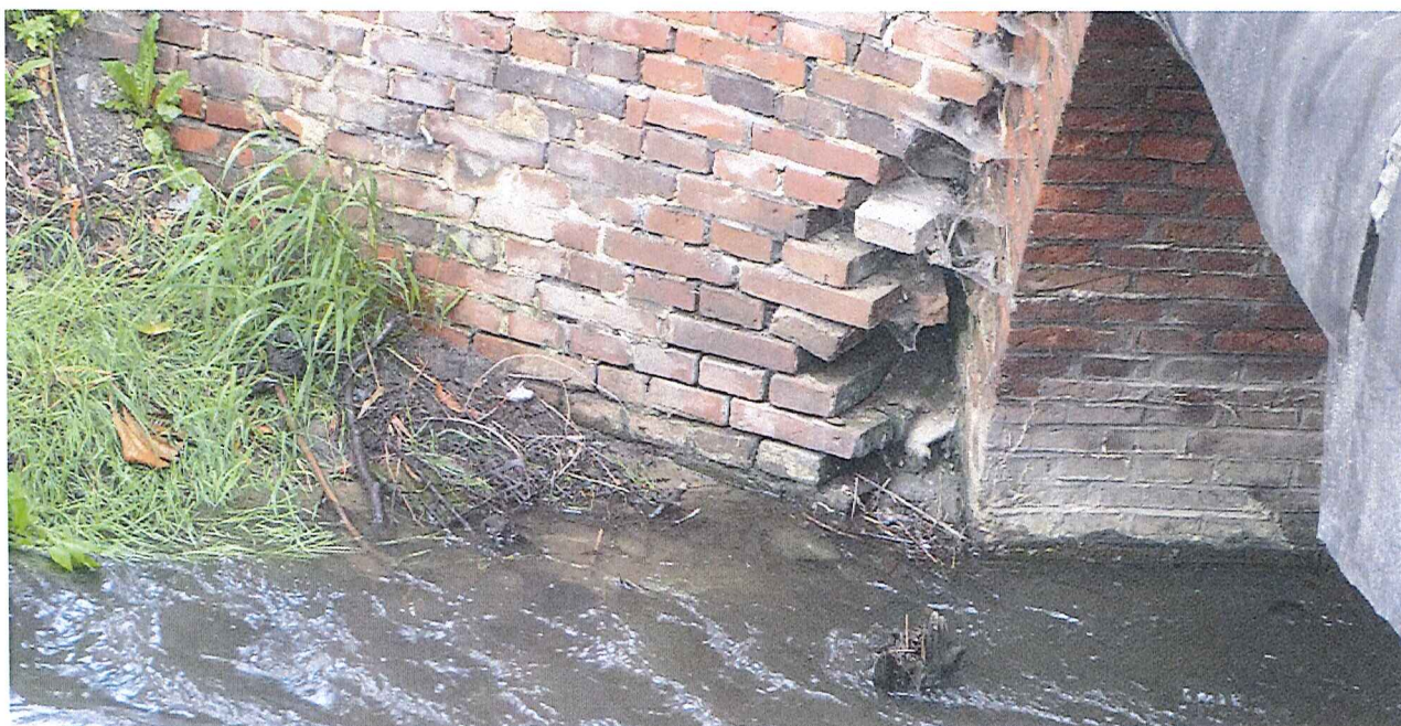
Fot. 8 Widok przestrzeni podmostowej
