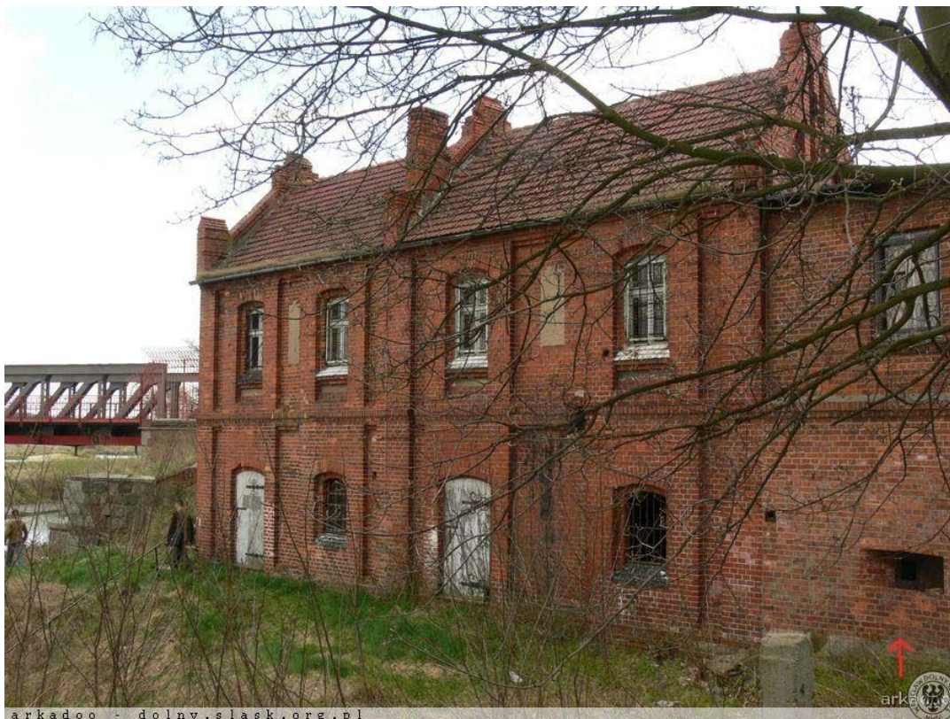
Fot 1. Obiekt tzw. roгатki będący w istocie schronem bojowym. W głębi przeszło mostu drogowego nad kanałem portowym
