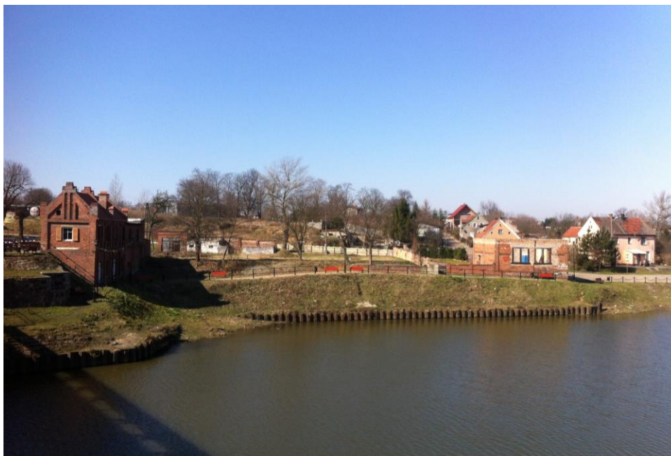
Fot 12. Oskarpowanie wraz z grodzicami nabrzeża portowego na odcinku od mostu drogowego do byłego placu składowego portu.
