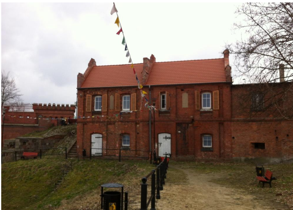
Fot 11. Ciąg pieszy prowadzący w kierunku mostu drogowego i obiektu aktualnej tawerny (dawniej Rogatka mostowa) będącego w istocie schronem bojowym pasa umocnień odrzańskiej drogi wodnej. Po lewej, obok schodów kamienny przyczółek mostowy.
