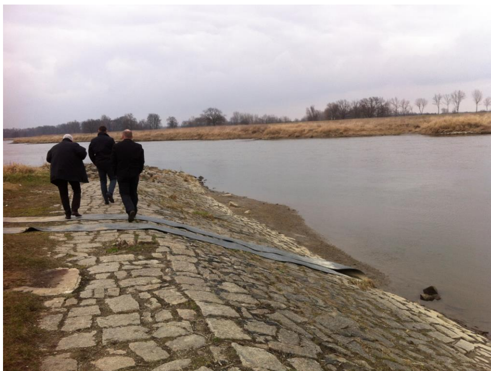
Fot 10. Oskarpowanie nabrzeża portowego w części bezgrodzicowej.
