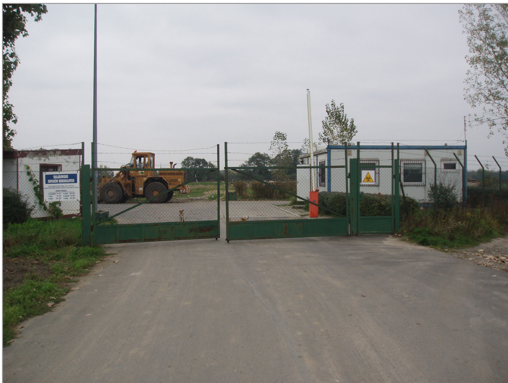
Fot. 1 Brama wjazdowa na składowisko odpadów
